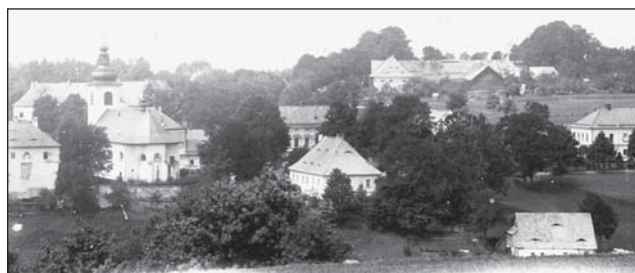
☐ Pohled na Rokytnici, kde je v pravé části snímku celkový pohled na areál pivovaru (20. léta 20. století).
