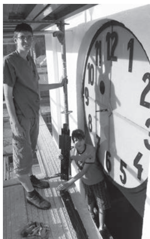
Oprava ciferníku hodin v r. 2012.
