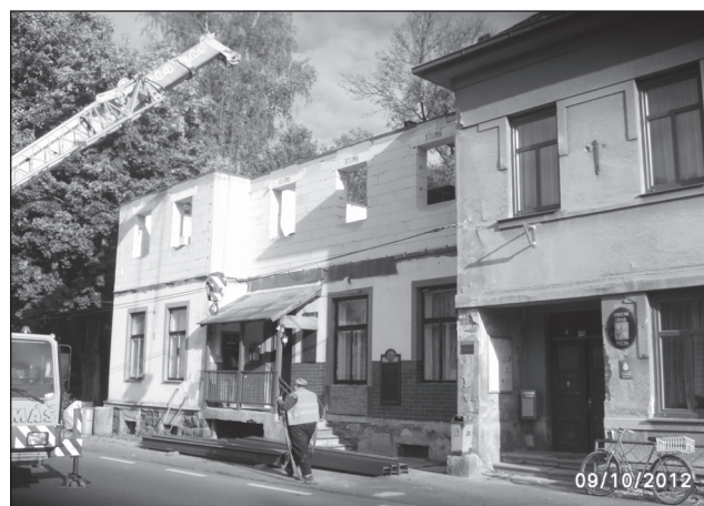
❑ Probíhající rekonstrukce – podzim roku 2012. Foto: M. Petr
