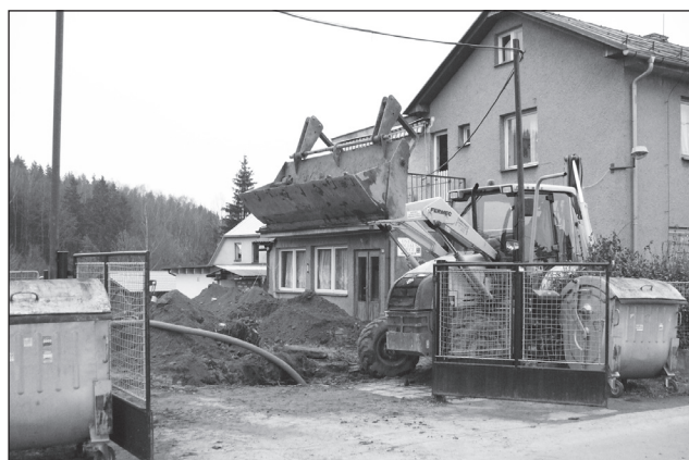
☐ Zahájení přestavby ústavu na Domov
