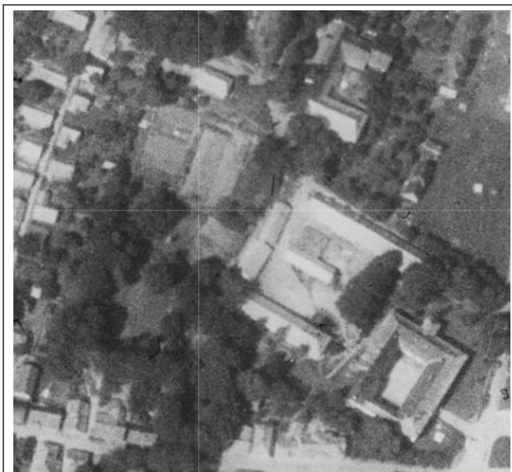
Obr. č. 9: Ortofoto zámeckého areálu z 50. let 20. stol., zdroj: http://kontaminace.cenia.cz/ .
